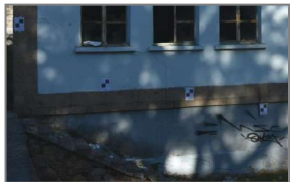
Εικόνα 1: Τοποθετημένοι στόχοι στην πρόσοψη του κτηρίου
